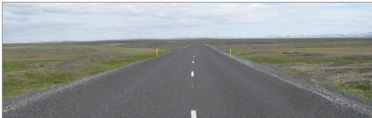
Mynd 8. Dettifossvegur sem er hannaður í um 1,0-1,5 m hæð yfir landi (mynd: Helga Aðalgeirsdóttir, 2014).
